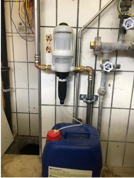
Dosatron zur Zudosierung einer geringen Menge Desinfektionsmittel, zur Tränkwasserstabilisierung.
